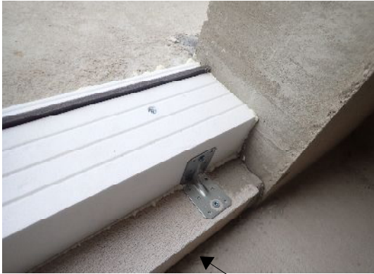
Częściowe podmurowanie betonem komórkowym pod ciepłą podwaliną z Klinarytu
