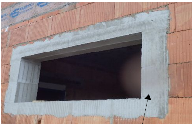
Prawidłowo przygotowane otwory
