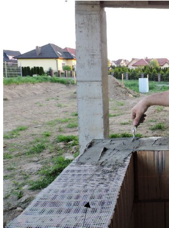
Wygładzenie podstawy otworu (siatka + zaprawa klejowa)
