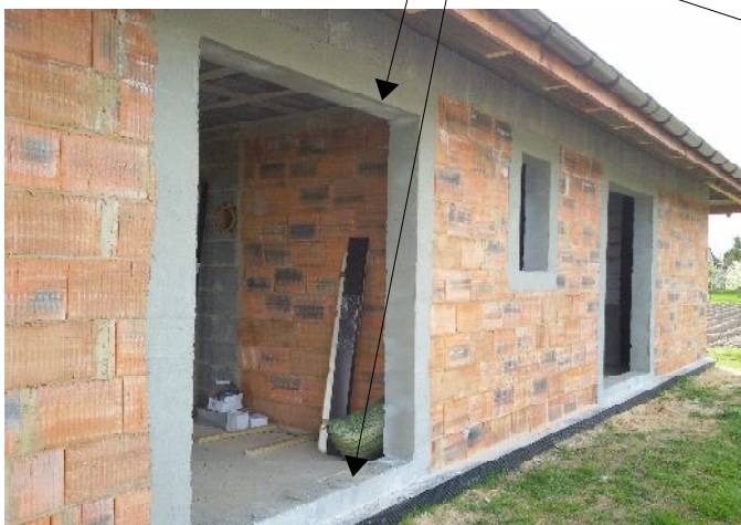
Prawidłowo przygotowane otwory
